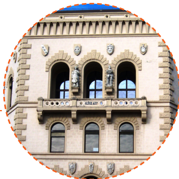
Abb. 6: Ehemalige Bergwerksdirektion, Saarbrücken
