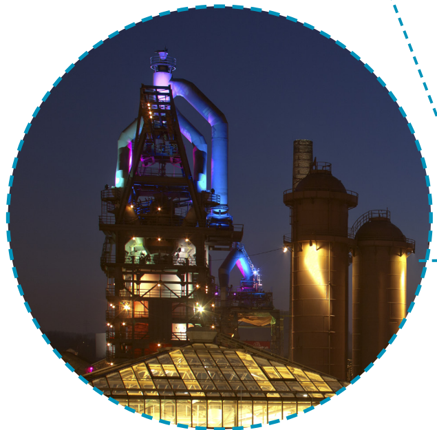
Abb. 57: Hochofen im Alten Hüttenareal, Neunkirchen
